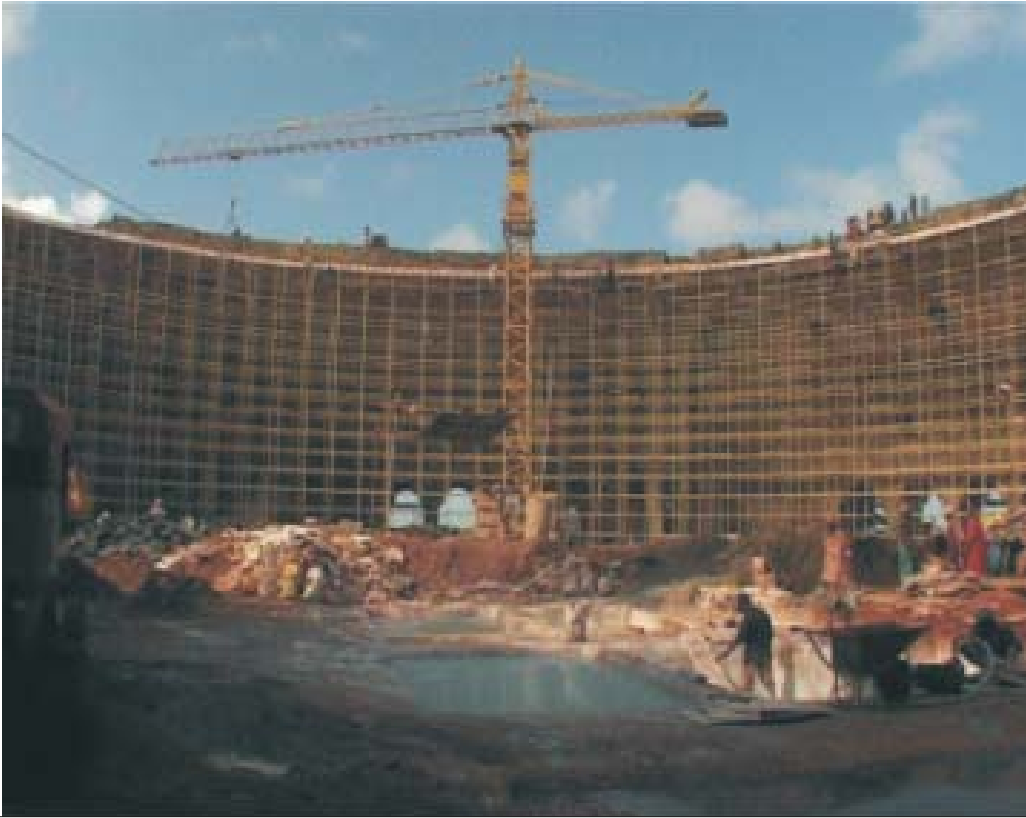
गुम्बद की ऊपर उठती दीवार का भीतरी भाग और निर्माण के समय उसे सपोर्ट करती स्के फोल्डिंग (छायाचित्र जून, २००५)
